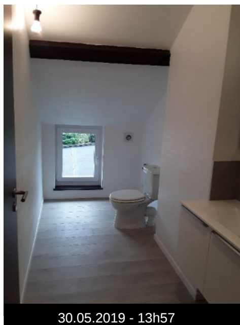
Photo 32 (Photo générale / Salle de bains)
