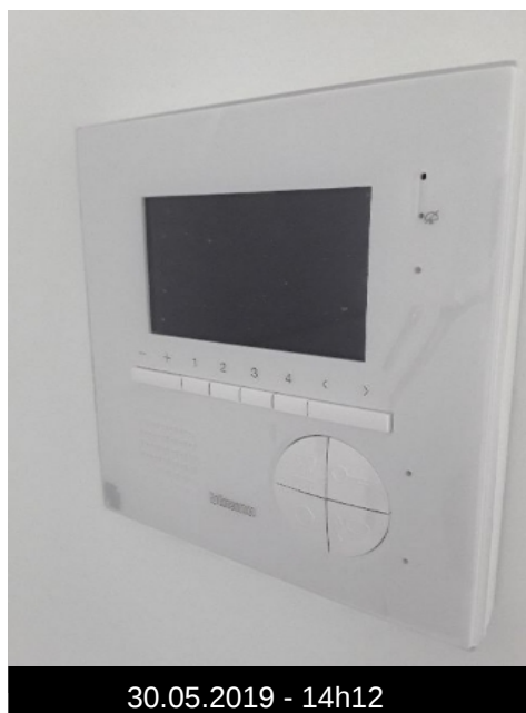
Photo 36 (Hall entrée / Interphone / Neuf)
