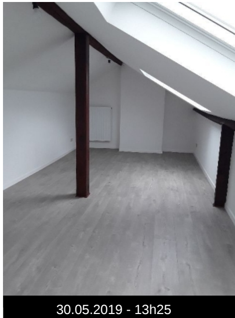
Photo 21 (Photo générale / Chambre mansarde )
