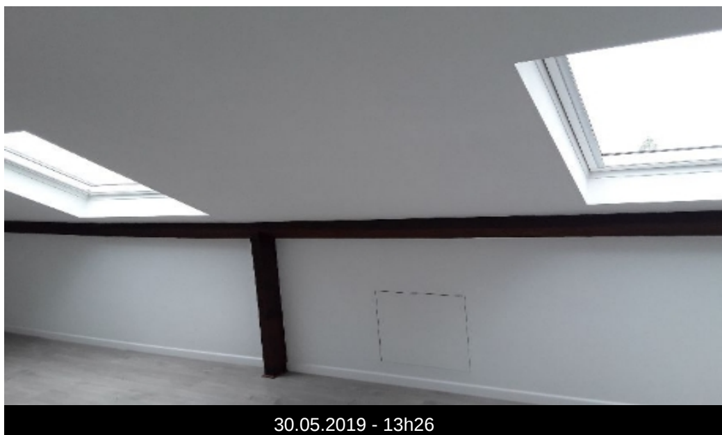
Photo 23 (Photo générale / Chambre mansarde )
