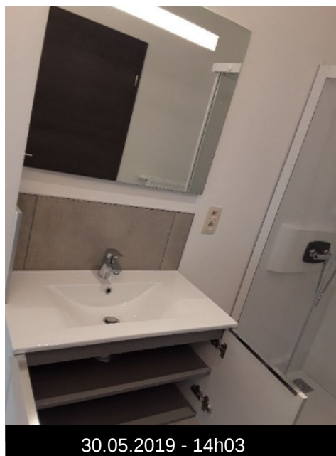
Photo 34 (Salle de bains / Lavabo / Neuf)
